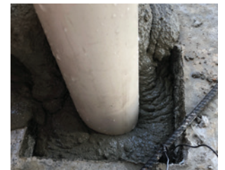
Grout sendo despejado.
