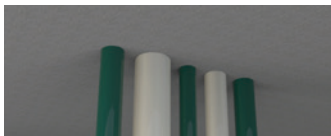
Imagem 5 - Shaft grauteado | Vão fechado
