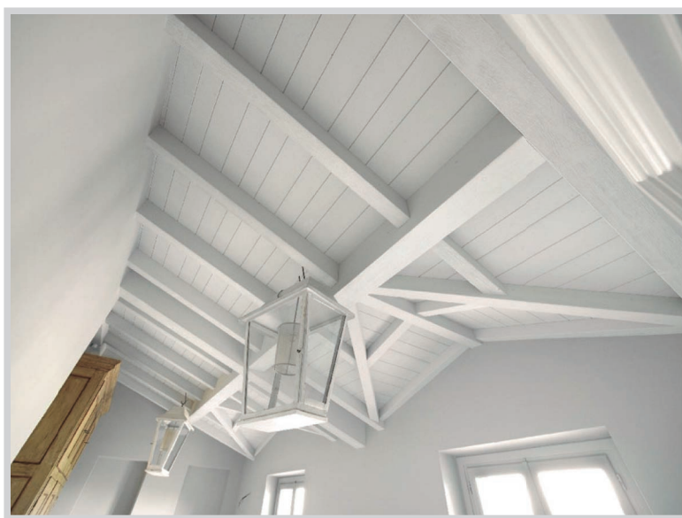
Forro e cobertura de madeira
