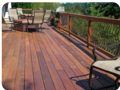
proteção de pisos e decks abertos
