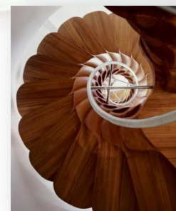
proteção de escadas e mezaninos
