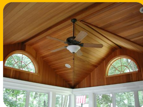
proteção de forro e vigas
